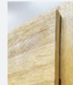
(występuje w drzwiach o gr. 82 mm) – skrzydło nie licuje się z ościeżnicą
