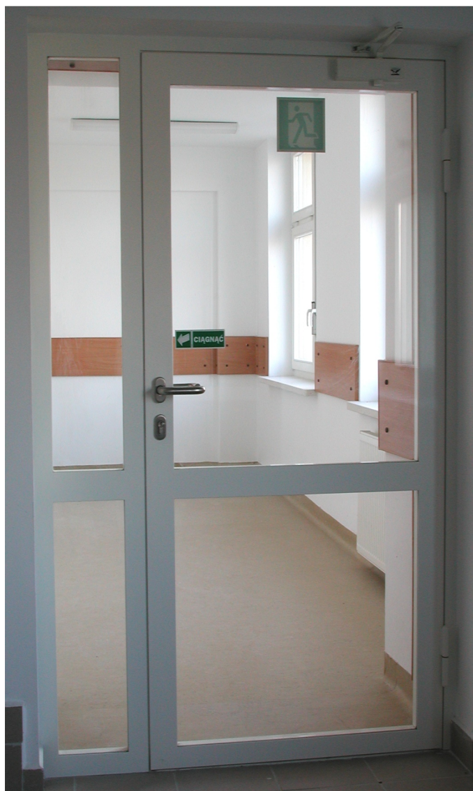
Drzwi EI30 - profilowe z ościeżnicą wewnętrzną i doświetleniem bocznym
