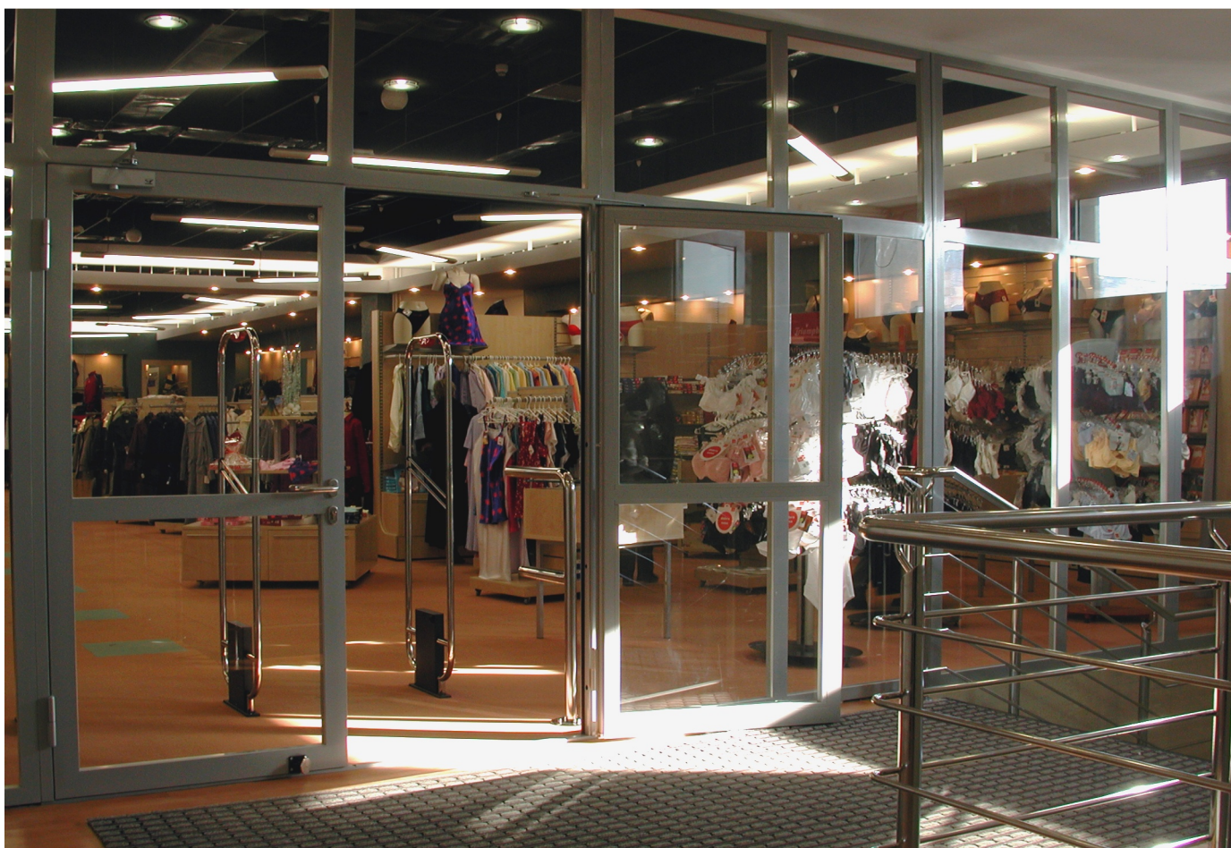
Ścianka profilowa EI60 z drzwiami dwuskrzydłowymi
