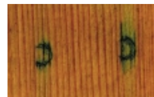
Bez stosowania mleczka pielęgnacyjnego: Poprzez mikropęknięcia woda wnika do drewna i powoduje siniznę
