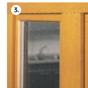
3. Okna drewniane błyszczą nowym połyskiem i są odporne na czynniki atmosferyczne
