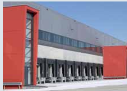
Centrum logistyczne Immogate, Monachium
