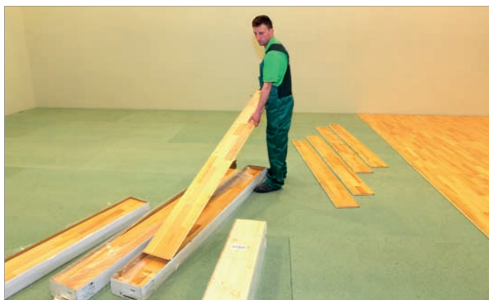
Zdjęcie 21. Otwieramy kilka opakowań z deskami i układamy wzór podłogi przed jej montażem. Pozwoli nam to na uzyskanie estetycznego wyglądu podłogi.
