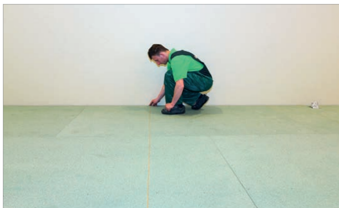
Zdjęcie 17. Po zamontowaniu wszystkich płyt OSB na konstrukcji drewnianej wyznaczamy środek podłogi i trasujemy miejsce układania deski startowej.
