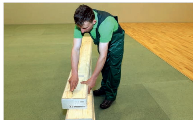
Zdjęcie 18. Na minimum 48 godzin przed montażem deski sportowej musi być ona aklimatyzowana w nieotwieranych fabrycznych opakowaniach.
