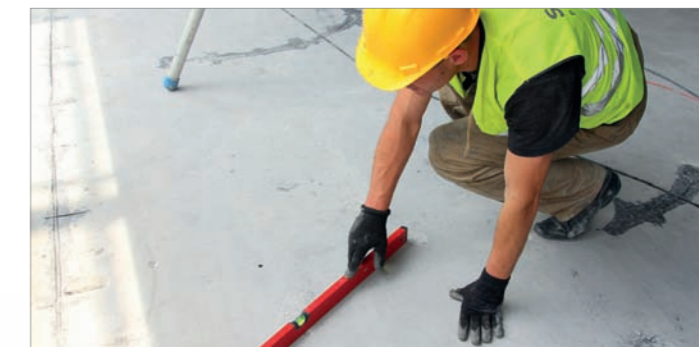
ZDJĘCIE 2. POMIAR PŁASZCZYZNY – DOPUSZCZALNY MARGINES BŁĘDU WYNOŚI +/- 3 MM, NA DŁUGOŚCI 3 M.
