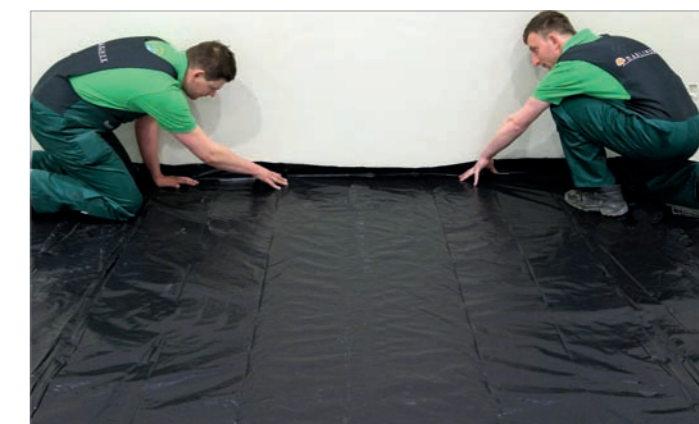
ZDJĘCIE 4. IZOLACJA PRZCIWWILGOCIOWA – ISTOTNE JEST, ABY POMIĘDZY ŚCIANĄ A PODŁOGĄ POZOSTAWIĆ ODPOWIEDNIO DUŻY ZAPAS FOLII.
