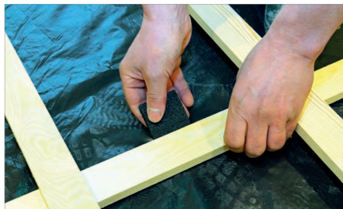
Zdjęcie 11. Pod tak przygotowaną konstrukcją krzyżową musimy podłożyć podkładki elastyczne. Podkładki o wymiarach 18 mm x 50 mm x 50 mm wykonane są ze sztucznego tworzywa o współczynniku sprężystości przy ściskaniu E_c = 2,85 \text{ N/mm}^2 oraz gęstości 725 \text{ kg/m}^3 . Podkładki elastyczne podkładamy pod dolny legar w połowie rozstawu pomiędzy połączeniami z legarami warstwy górnej.
