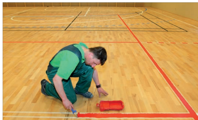
Zdjęcie 27. Do malowania linii stosowane są jedno lub dwuskładnikowe farby poliuretanowe do malowania nawierzchni drewnianych. Farby te są bardzo odporne na ścieranie i są dostępne w kolorach jakie są wymagane przy oznakowaniu boisk dla poszczególnych konkurencji sportowych.
