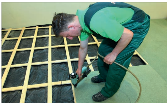
Zdjęcie 16. Płytę OSB mocujemy do legarów warstwy górnej za pomocą wkrętów do drewna 3,2 x 35 mm lub za pomocą zszywek ocynkowanych o długości 38 mm w rozstawie około 300 mm. Płyta powinna być montowana na legarach w sposób mijankowy z przesunięciem min. 500 mm. Pomiędzy krawędziami płyt a ścianą powinna być zostawiona szczelina dylatacyjna o szerokości około 15 mm.
