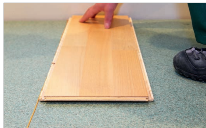
Zdjęcie 19. Deska startowa posiada dwa wpusty pozwalające na symetryczne dokładanie desek sportowych po jej obydwu stronach. Pozwala to na przyśpieszenie prac monterskich.
