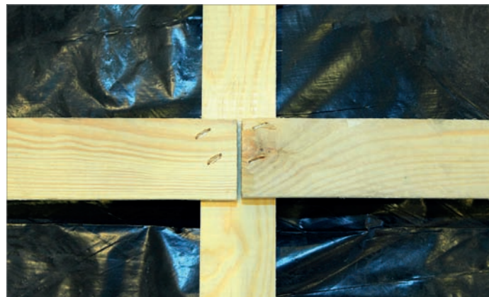
Zdjęcie 10. Połączenia wzdłużne legarów warstwy górnej wykonujemy za pomocą zszywek. Pomiędzy czołami legarów zostawiamy szczelinę 2 - 3 mm i każdy legar łączymy mechanicznie za pomocą dwóch zszywek.
